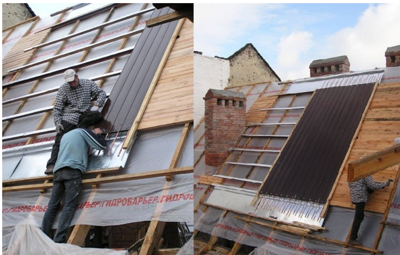
Сооружение энергоактивной крыши
