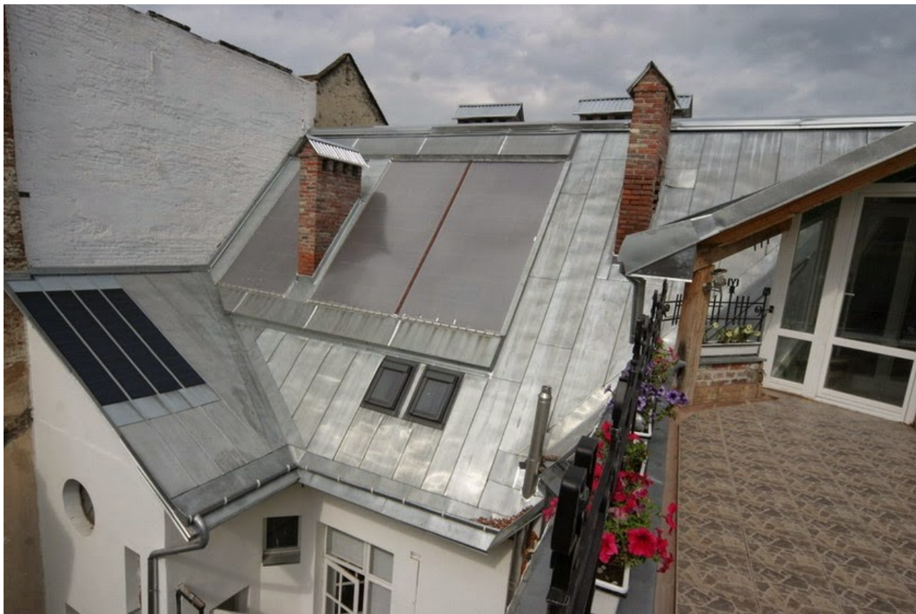
Здание с элементами концепции «Энергоактивное здание» (Львов, Украина)
