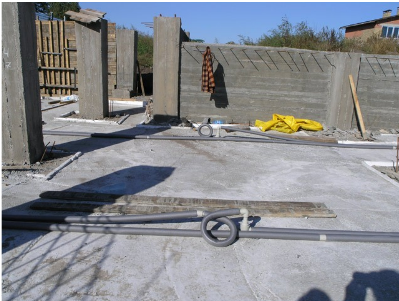
Сезонный грунтовый аккумулятор тепла
